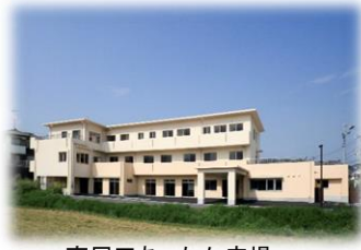
高尾田あったか広場 (サービス付き高齢者住宅)
