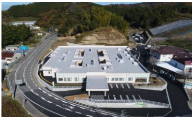
五明苑 外観俯瞰図(上が北)
